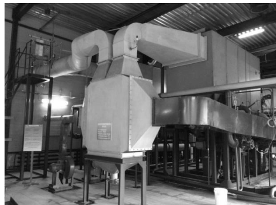
Рис 2. Внешний вид котлов с топками НТКС и ВТКС
