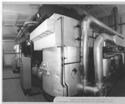
Рис 2. Внешний вид котлов с топками НТКС и ВТКС
